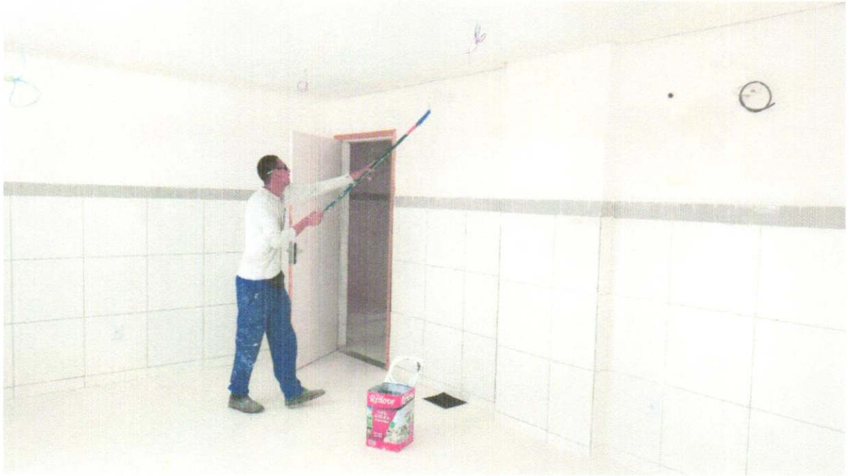
FOTO 27 - APLICAÇÃO MANUAL DE PINTURA COM TINTA LÁTEX ACRÍLICA EM TETO, DUAS DEMÃOS. AF_06/2014
