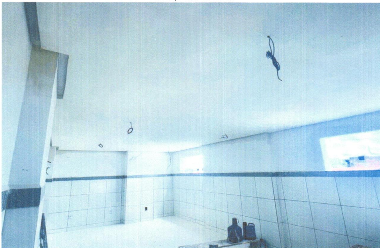
FOTO 26 - EMASSAMENTO COM MASSA A OLEO, DUAS DEMAOS
