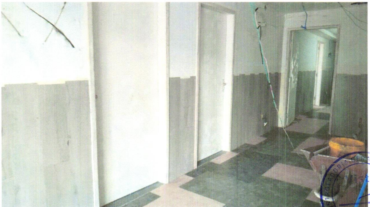
FOTO 14 - PISO VINÍLICO SEMI-FLEXÍVEL EM PLACAS, PADRÃO LISO, ESPESSURA 3,2 MM, FIXADO COM COLA. AF_09/2020
