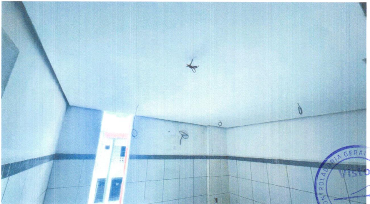
FOTO 22 - FORRO EM PLACAS DE GESSO, PARA AMBIENTES COMERCIAIS. AF_05/2017_P
