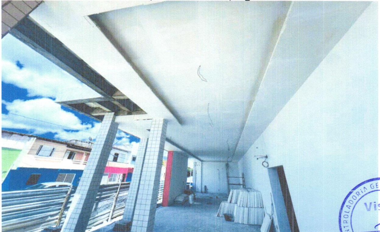
FOTO 16 - ACABAMENTOS PARA FORRO (MOLDURA DE GESSO). AF_05/2017
