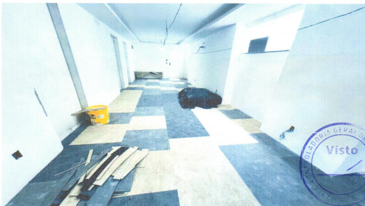
FOTO 26 - EMASSAMENTO COM MASSA A OLEO, DUAS DEMAOS
