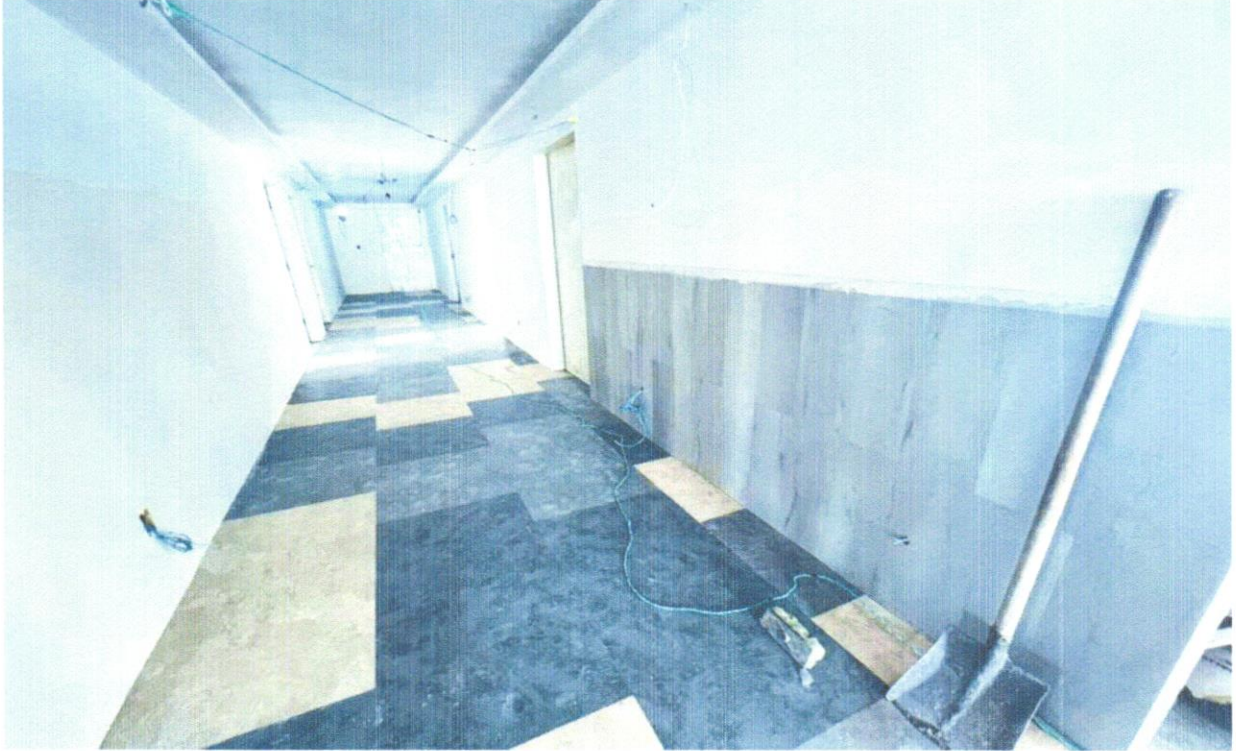
FOTO 12 PISO VINÍLICO SEMI-FLEXÍVEL EM PLACAS, PADRÃO LISO, ESPESSURA 3,2 MM, FIXADO COM COLA. AF_09/2020
