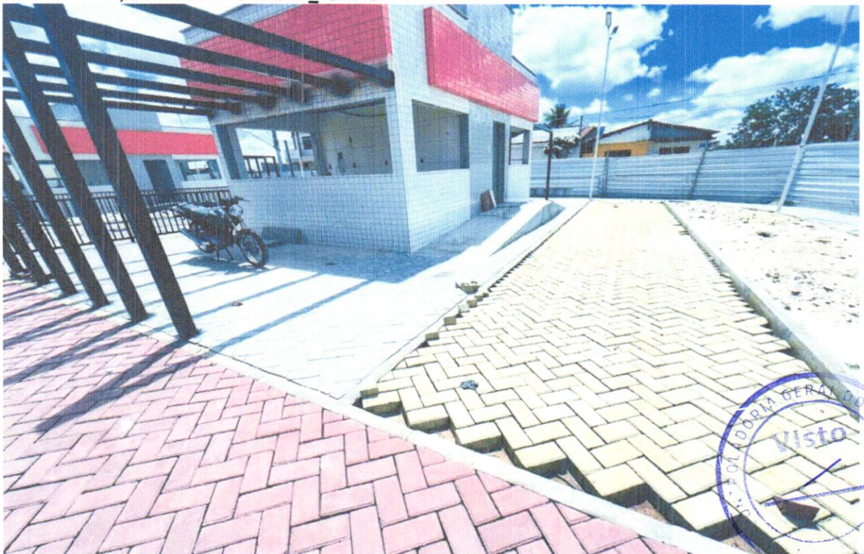
FOTO 42 - EXECUÇÃO DE PASSEIO EM PISO INTERTRAVADO, COM BLOCO RETANGULAR COLORIDO DE 20 X 10 CM, ESPESSURA 6 CM. AF_12/2015
