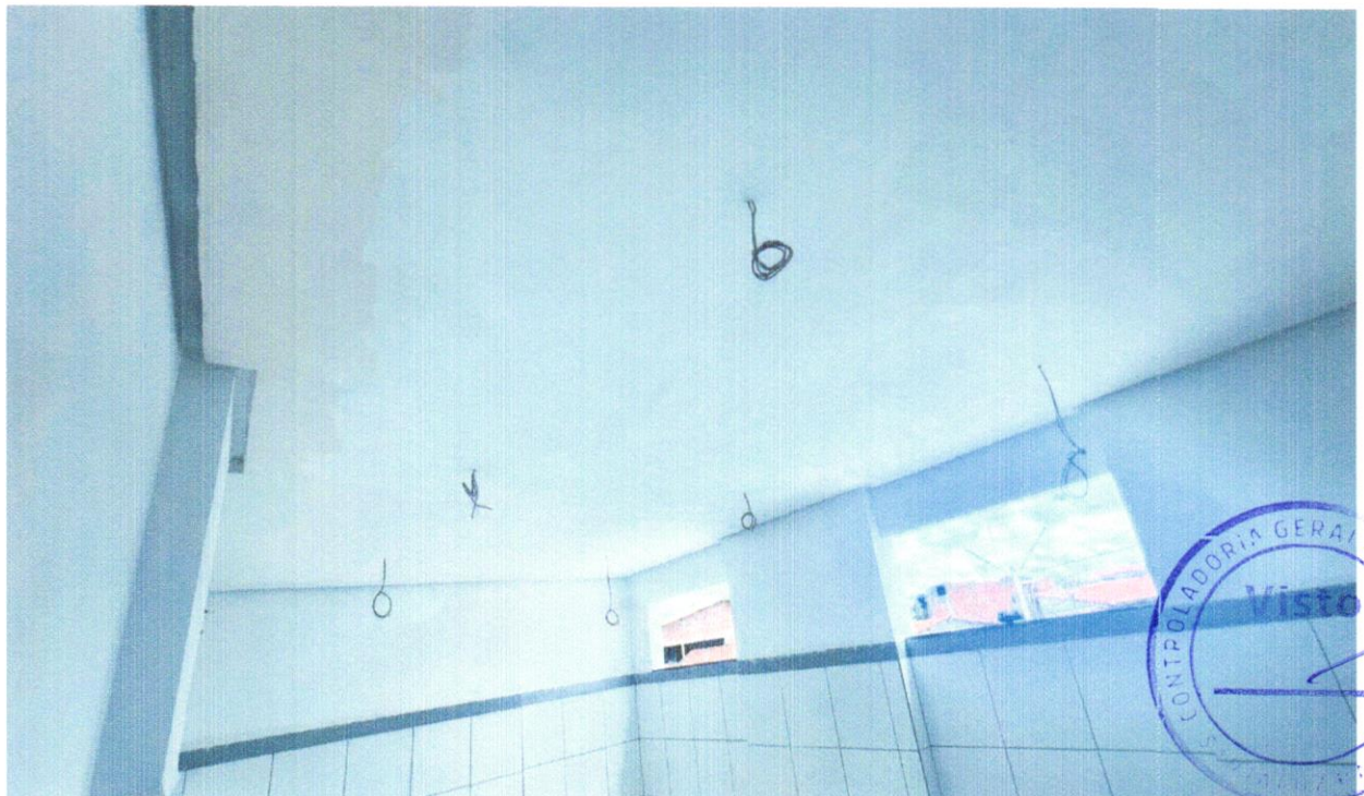
FOTO 24 - EMASSAMENTO COM MASSA A OLEO, DUAS DEMAOIS
