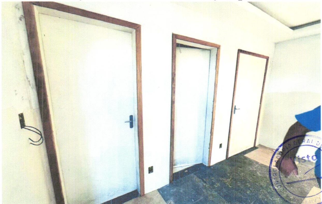
FOTO 30 - KIT DE PORTA DE MADEIRA PINTADA, SEMI-OCA (LEVE OU MÉDIA), 90X210CM, ESPESSURA DE 3,5CM, ITENS INCLUSOS: DOBRADIÇAS, ALIZAR, MONTAGEM E INSTALAÇÃO DO BATENTE, FECHADURA COM EXECUÇÃO DO FURO - FORNECIMENTO E INSTALAÇÃO. AF_12/2019
